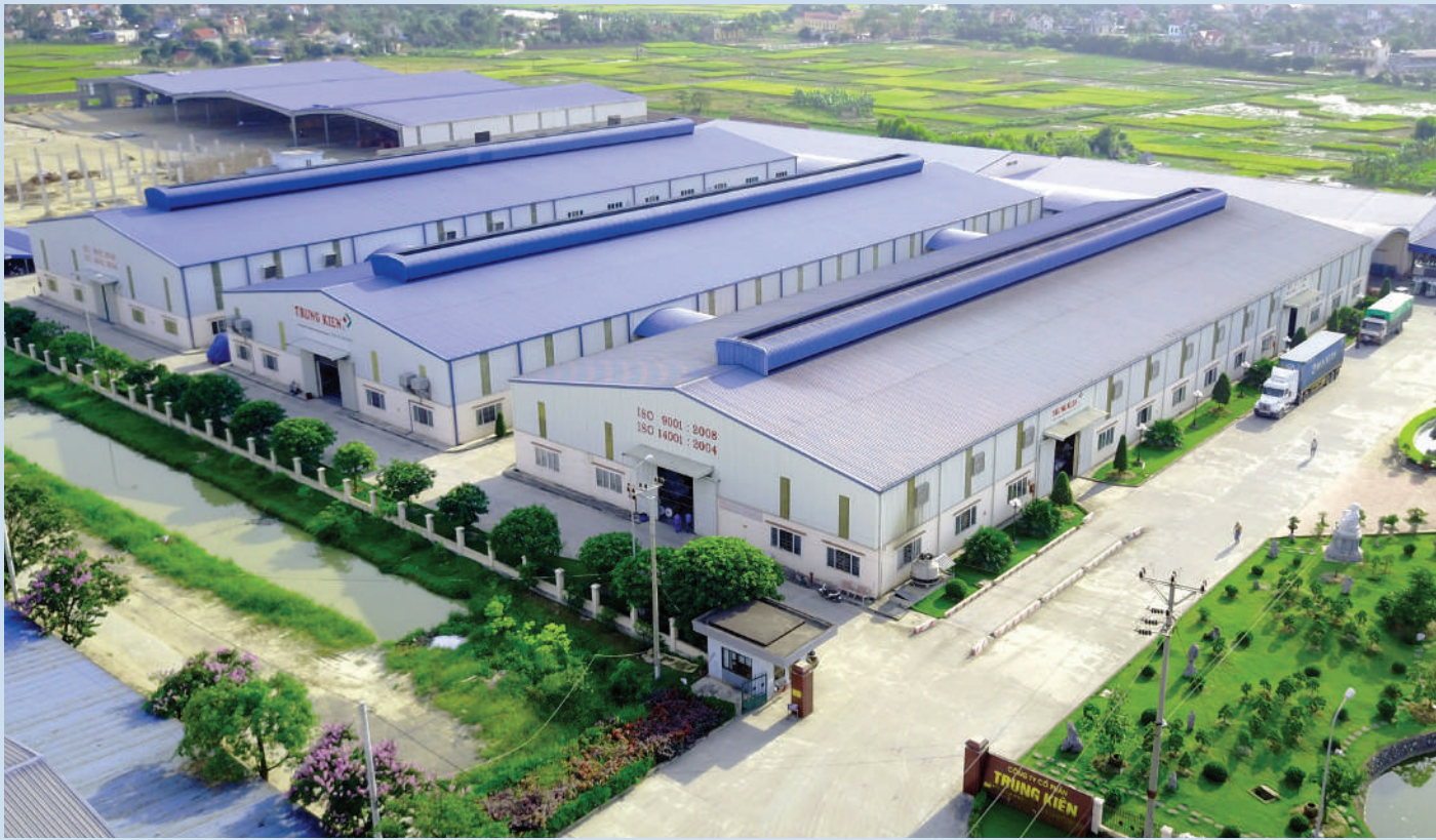
NHÀ MÁY HYUNDAI TC MORTOR / HYUNDAI TC MORTOR FACTORY
