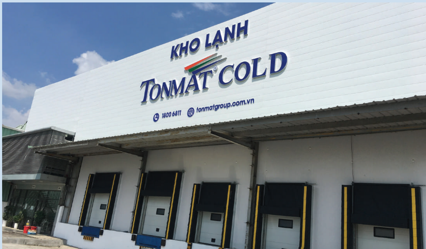
HỆ THỐNG KHO LẠNH TONMAT COLD / TONMAT COLD WAREHOUSE SYSTEM
