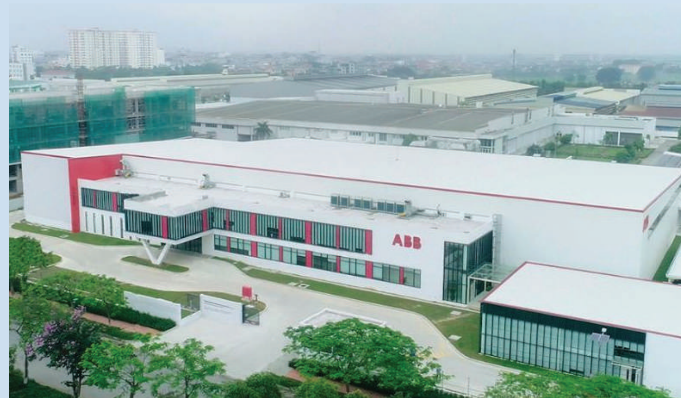
CÔNG TY TNHH ABB - CHI NHÁNH BẮC NINH / ABB LTD., BACNINH BRANCH
